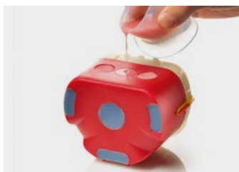
13. Fin del vaciado a la salida de la resina de los canales laterales
